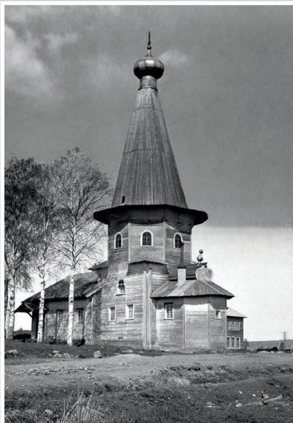
Погост Космозеро. Церковь прп. Александра Свирского (1770 г.). Вид с юго-востока. 28 мая 1944 г.
