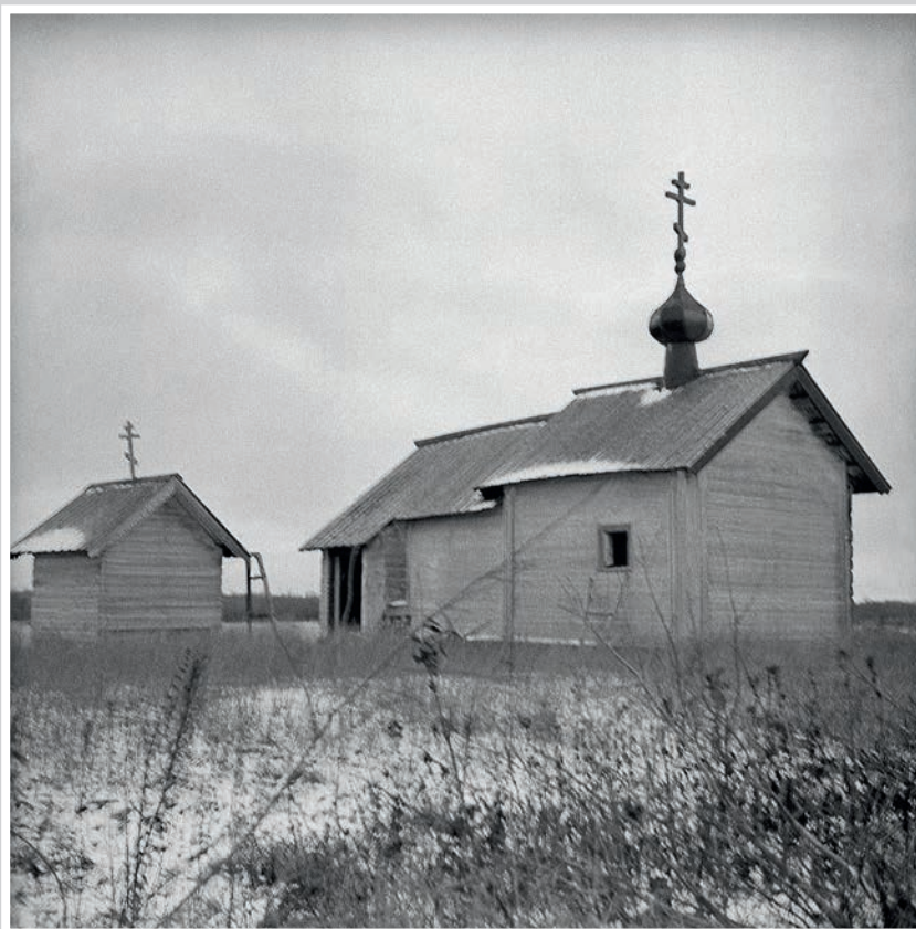
д. Вороний Остров (Типиницкий приход). Часовня Рождества Иоанна Предтечи на Ивановском острове (вт. пол. XVIII в.). Вид с юго-востока. 4 ноября 1942 г.
